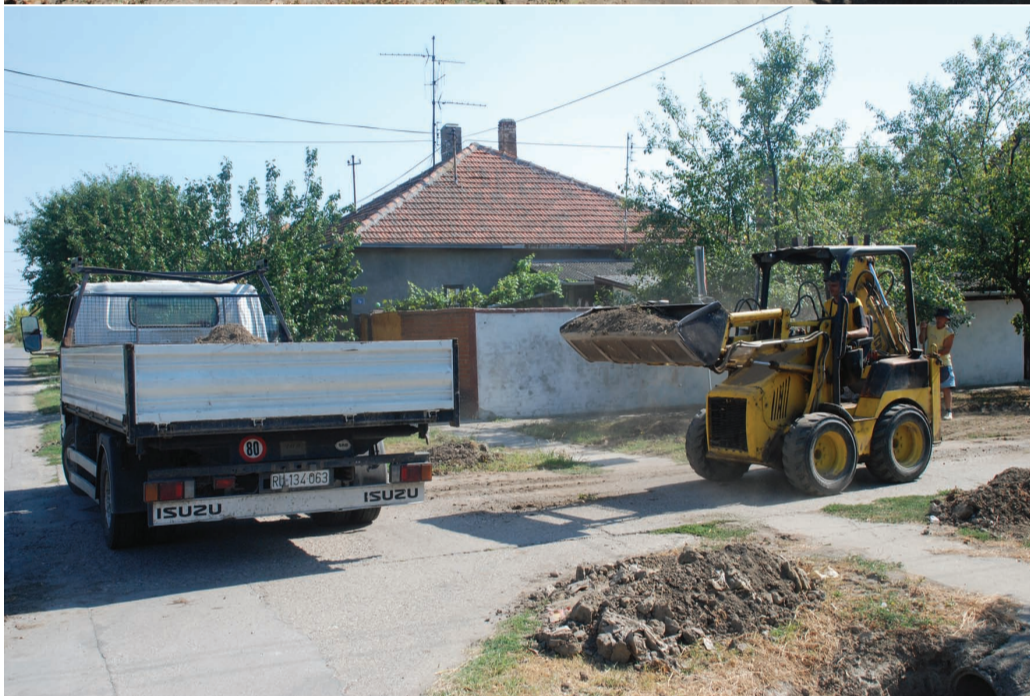
A kimélyítés utáni föld elhordása Csókán Одношење земље после продубљивања канала у Чоки
