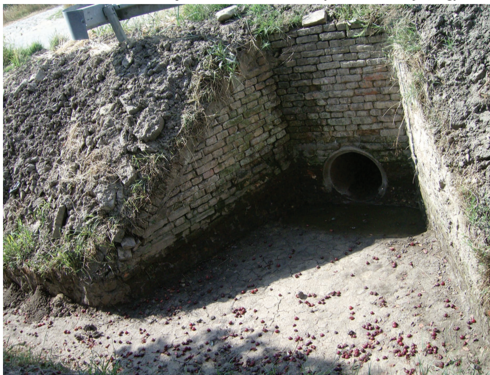
Árok az áteresztővel a munkálatok elvégzése után Feketetón Канал са пропустом у Црној Бари након извршених радова
