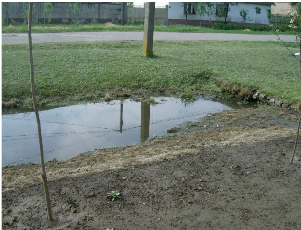
Канал без одговарајућег пропуста у Јазову Megfelelő átéresztő nélküli árok Hódegyházán
